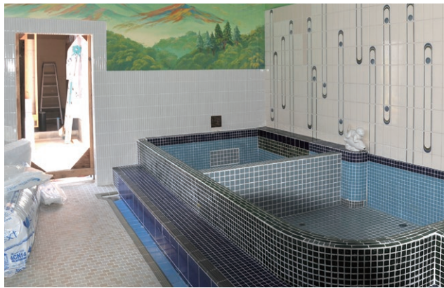
開業に向け、改装が進む浴槽、奥にはサウナが設置される
